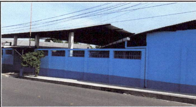
Foto 3: Repello de muros finalizado, se quita el rótulo ubicado en esta parte.
