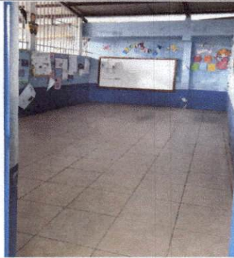
Foto1: Aula con su piso completo finalizado.
