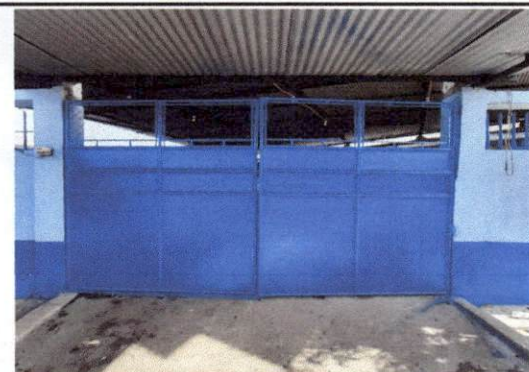
Foto 4: Remozamiento finalizado en el porton de la escuela.
