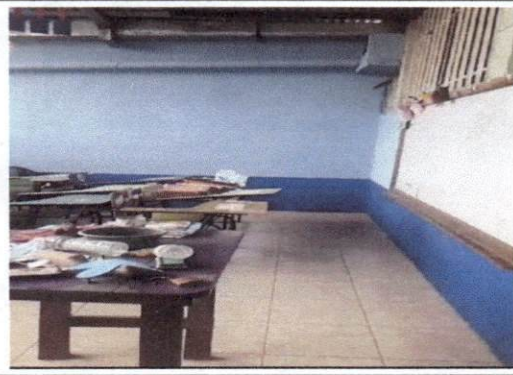
Foto 2: Repello de muros de un aula finalizado.
